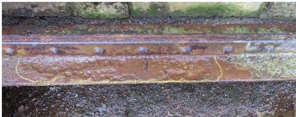
Obr. 28 Důlková koroze vodorovné příruby úhelníku dolního vodorovného ztužení nad P1
