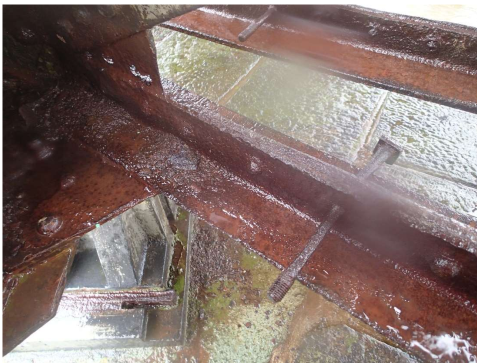
Obr. 32 Rozsáhlá důlková koroze dolního vodorovného ztužení nad podpěrou P2 (levá strana)
