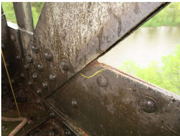
Obr. 23 Styk dolního pasu s taženou diagonálou – štěrbinová koroze na styku plechů
