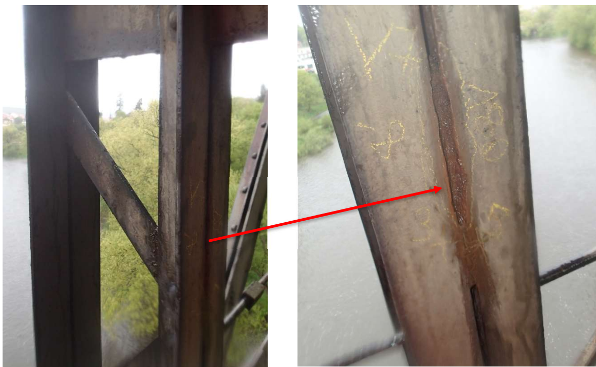
Obr. 36 Štěrbinová koroze mezi úhelníky svislice
