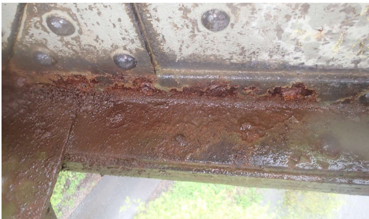
Obr. 22 Koroze plechu pásnice a postupné mizení hlav nýtů při dolní pase
