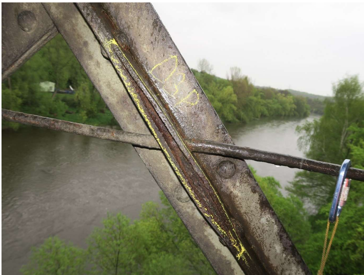
Obr. 24 Štěrbínová koroze mezi úhelníky tlačené diag. v místě prostupu revizního madla – deformace až 10 mm
