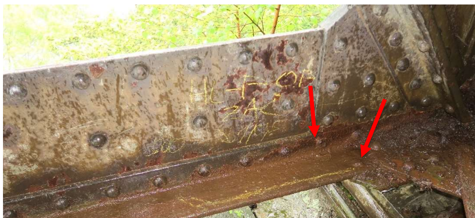
Obr. 29 Oslabení dolní pásnice a degradace hlav nýtů do špičky
