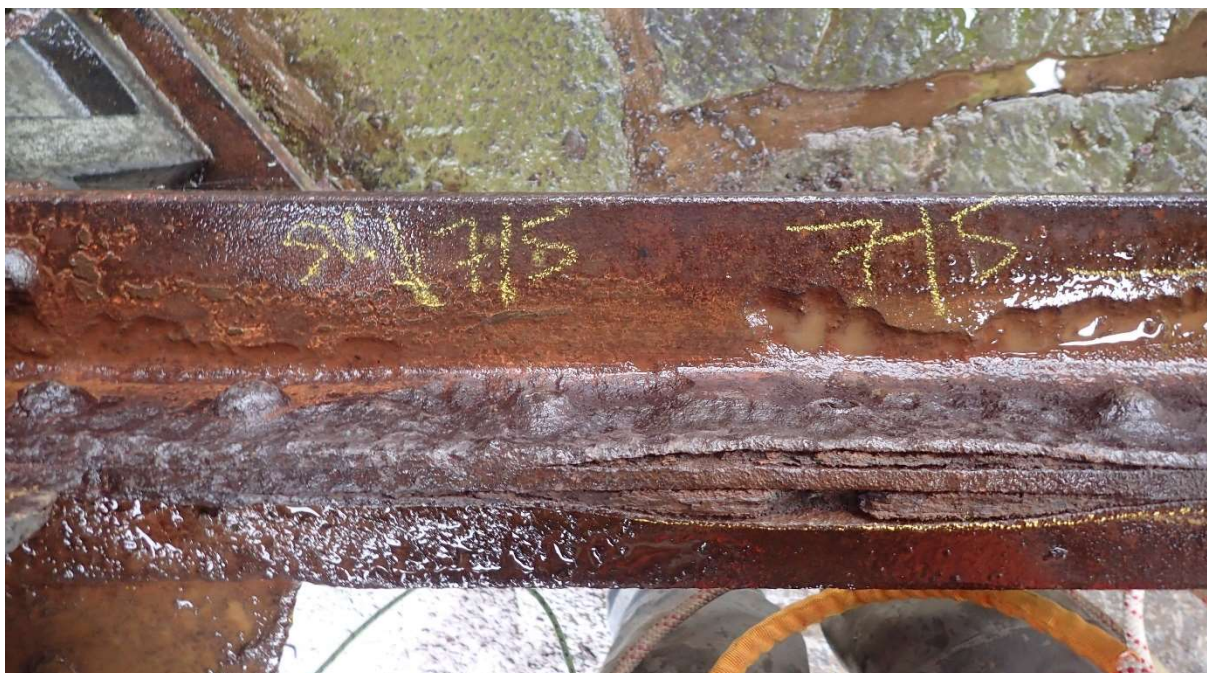
Obr. 44 Důlková koroze velkého rozsahu a štěrbinová koroze mezi plechy dvojice úhelníků příčného ztužení
