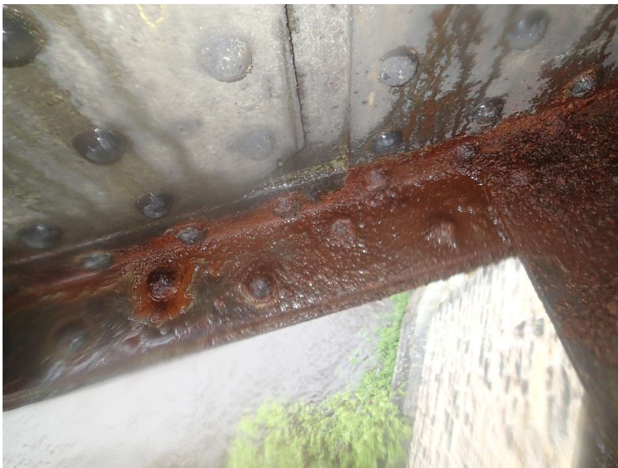
Obr. 37 Koroze vodorovné příruby krčních úhelníků dolního pasu
