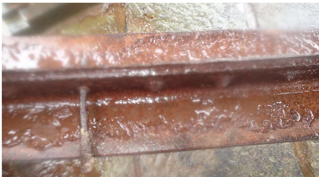
Obr. 38 Dolní vodorovné ztužení pod koncovým styčnickem s rozsáhlou důlkovou korozí
