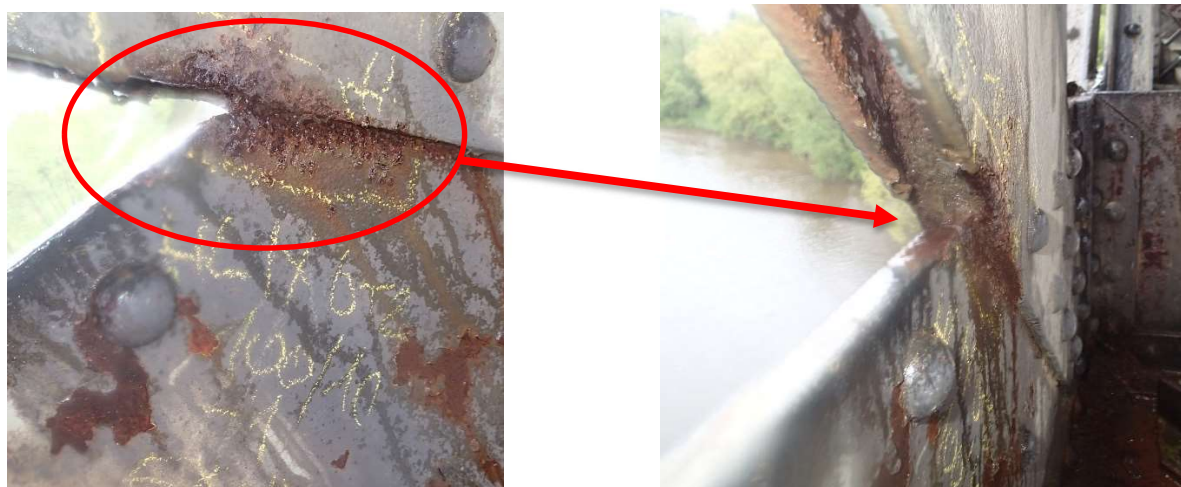
Obr. 34 Štěrbinová koroze mezi plechy tažené diagonály a stojinou dolního pasu - obecný stav
