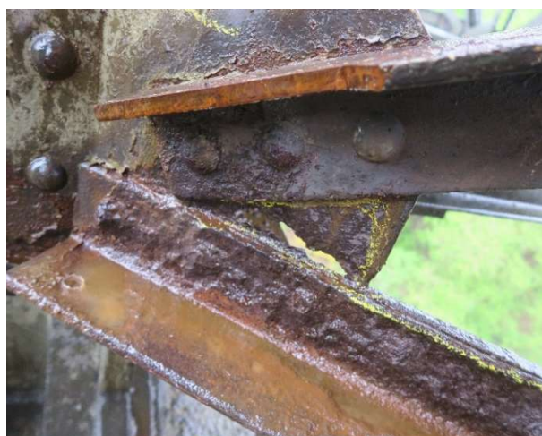
Obr. 30 Prokorodovaný nadpodporový styčnickový plech na pravé straně pilíře P2
