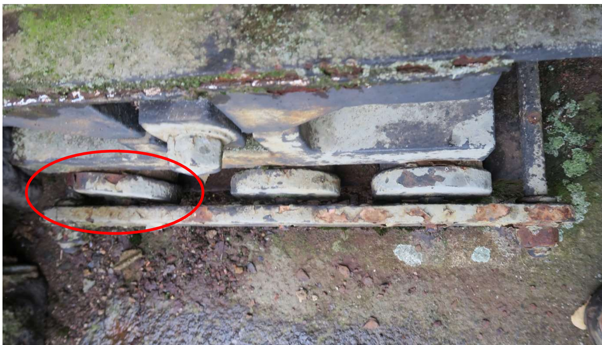
Obr. 33 Opěra P1 –Pravé pohyblivé ložisko, vzpříčený válec
