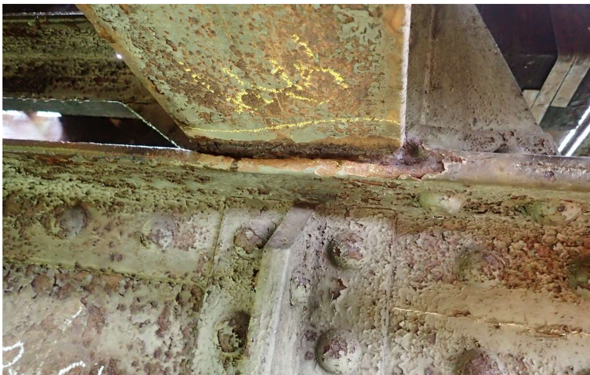
Obr. 42 Koroze pásnic podélníku a příčnicku na jejich styku - deformace od štěrbinové koroze – obecný stav
