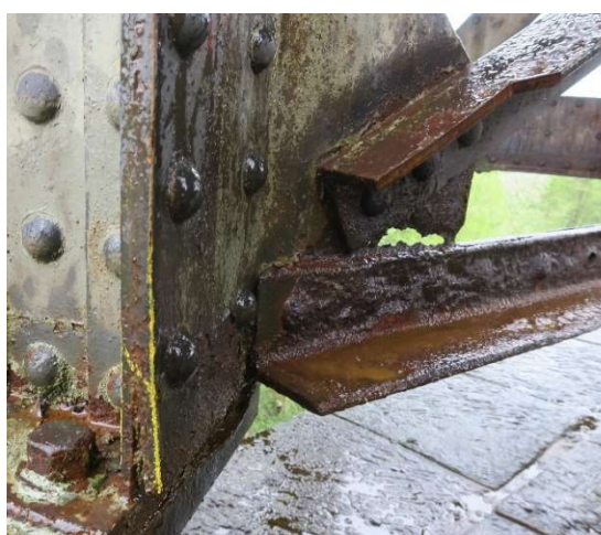
Obr. 30 Prokorodovaný nadpodporový styčnickový plech na pravé straně pilíře P2
