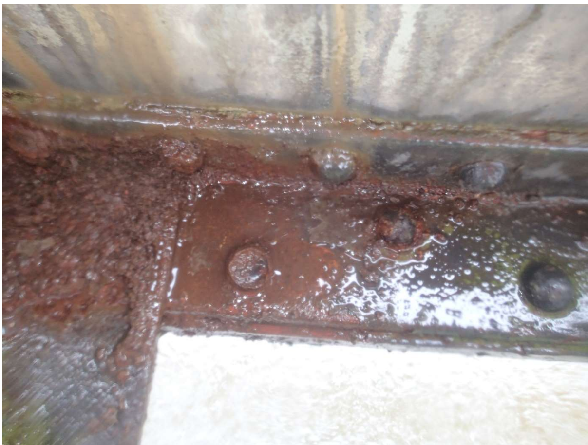
Obr. 35 Usazování nečistot a postupná koroze dolního pasu včetně nýtů
