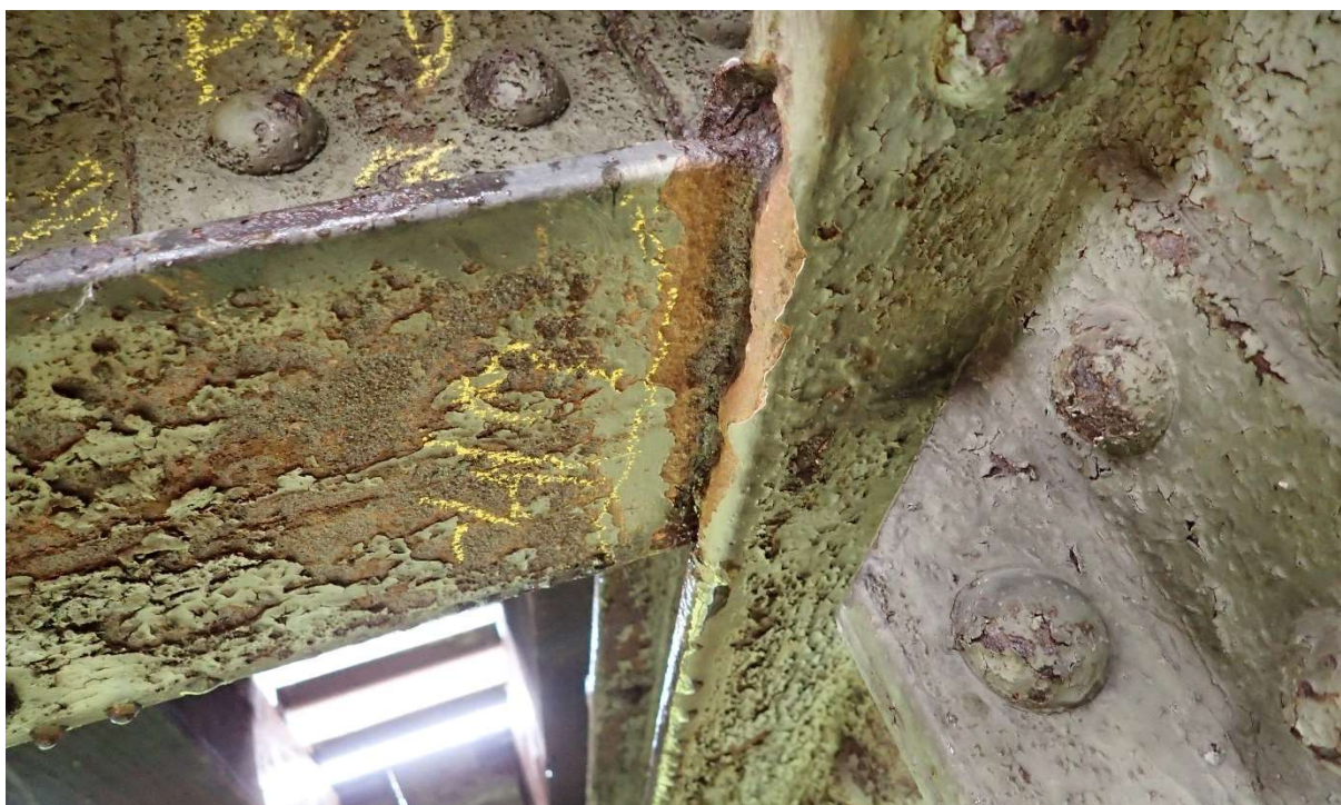
Obr. 41 Koroze pásnic podélníku a příčnicku na jejich styku - deformace od štěrbinové koroze – obecný stav
