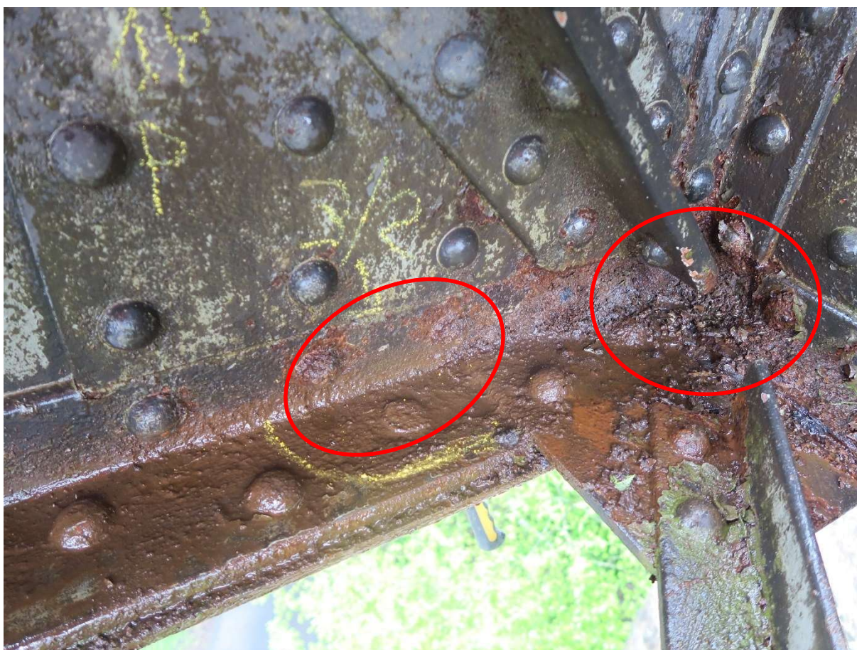
Obr. 21 Pásnice dolního pasu na styku s příčným ztužením – redukce pásnice a odkorodované hlavy nýtů, nečistoty a postupující hloubková koroze ve styčniku
