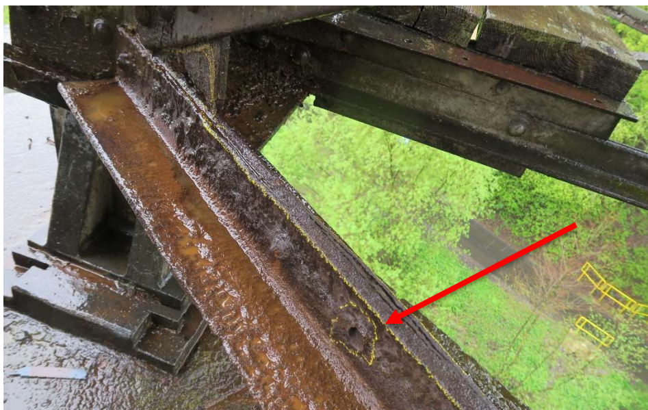
Obr. 31 Rozsáhlá důlková koroze dolního vodorovného ztužení nad podpěrou P2 (pravá strana)
