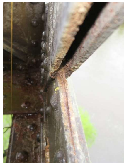
Obr. 23 Styk dolního pasu s taženou diagonálou – štěrbinová koroze na styku plechů
