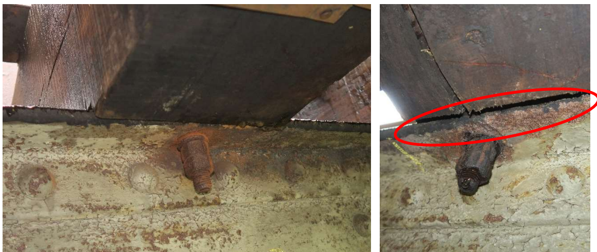
Obr. 25 Zatékání pod mostnice - obecně koroze pásnice podélníku pod mostnicemi a kotevních šroubů
