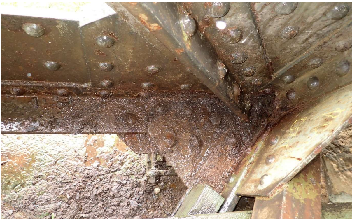
Obr. 43 Usazování nečistot u nadpodporového styčnicku
