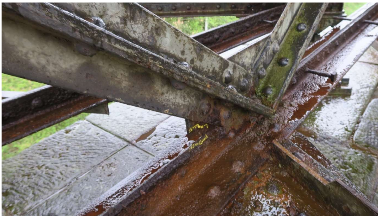
Obr. 39 prokorodování styčnickového plechu nadpodporového styčnicku prvků vodorovného a příčného ztužení
